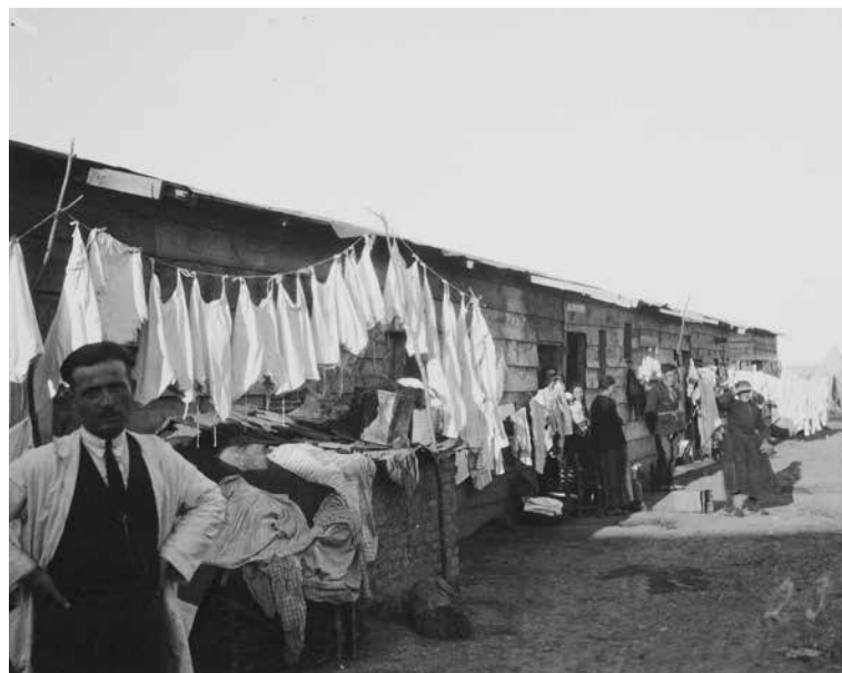
Εικ. 17. Τοψίν (Γέφυρα Θεσσαλονίκης), παράγκες προσωρινής εγκατάστασης. Πηγή: ΙΑΜΜ – Συλλογή φωτογραφιών Λένας Σαμαρά (371).
