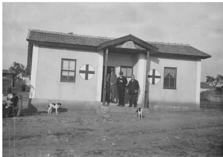
Εικ. 25. Ιατρείο που κατασκεύασε η ΕΑΠ στη Ν. Τρίγλια της Χαλκιδικής.
