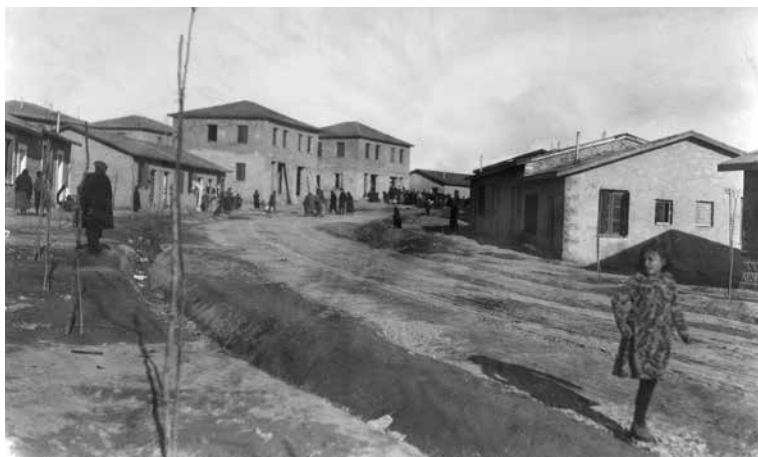
Εικ. 8. Άποψη οικημάτων του προσφυγικού οικισμού «Ποδαράδες» στην περιοχή της Νέας Ιωνίας, Αθήνα.
